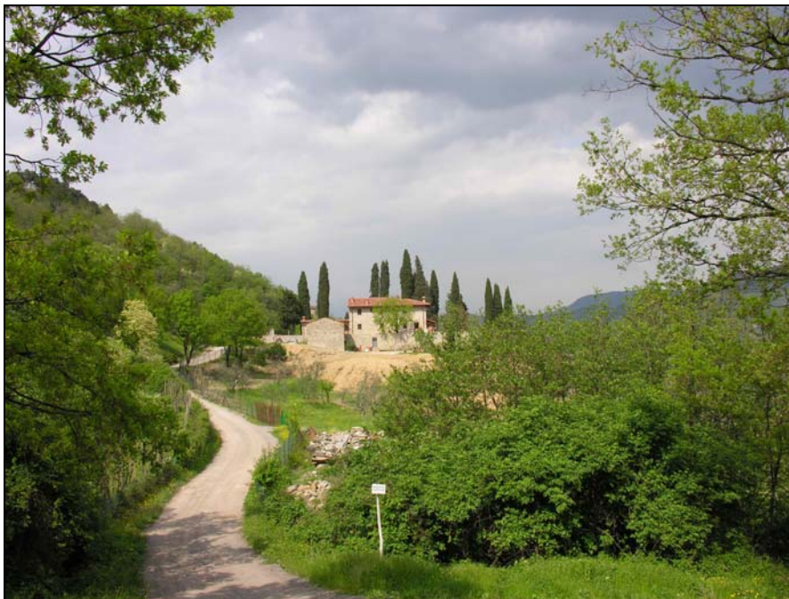
Descrizione: Il Podere di Casi 2 visto dalla strada di mezzacosta che conduce a Pratallame e alla Collina. Data: 28/04/2006
